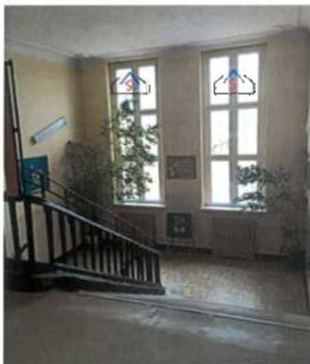
Klatka schodowa „A”
