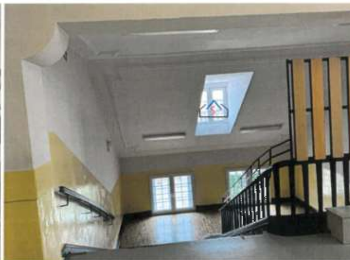
Klatka schodowa „B”
